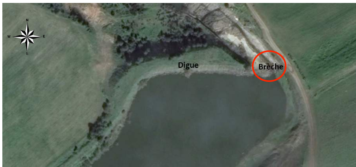
Figure 3. Situation de la brèche dans la digue du barrage (Google Earth)
