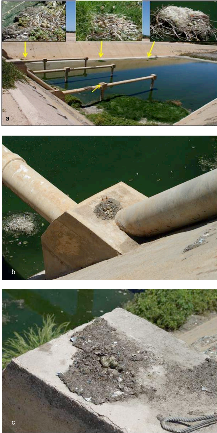
Figure 1. Emplacements des nids d'Échasses blanches dans le décanteur A
